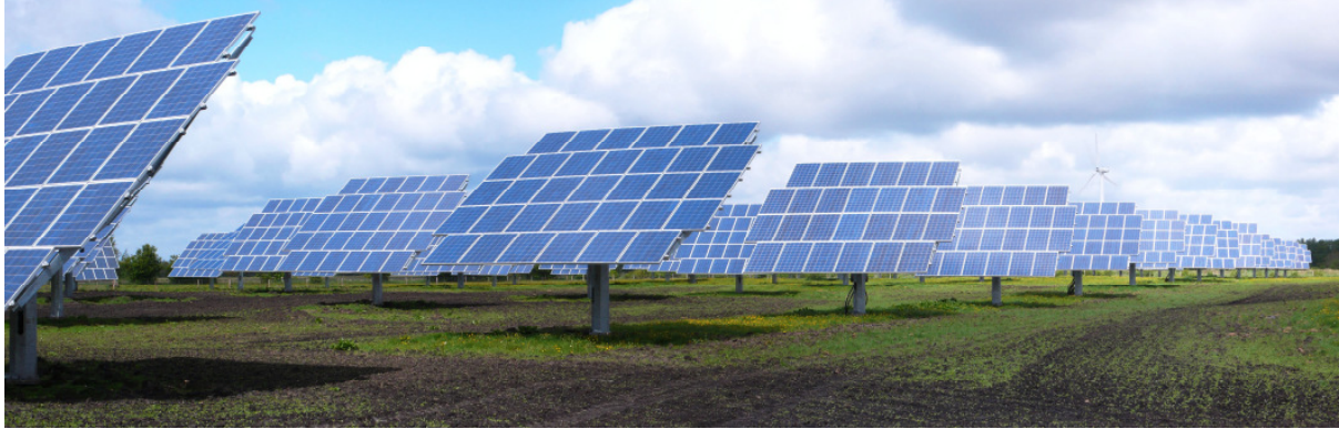
Freiflächenanlage der SunEnergy Europe GmbH in Sprakebüll (Nordfriesland/Schleswig-Holstein) mit zweiachsiger Nachführung
